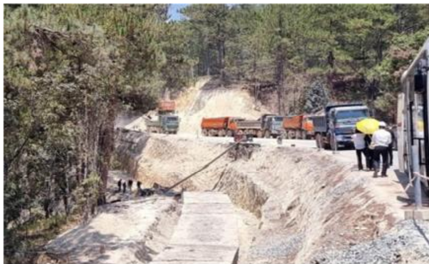
Nhà thầu huy động gần 100 đầu thiết bị và 450 nhân lực để đẩy nhanh tiến độ thi công.
