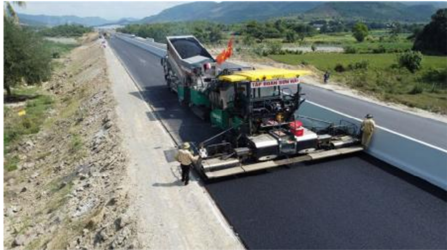
Dây chuyền công nghệ cung cấp vật liệu và thảm bê tông nhựa nóng hiện đại, được nhà đầu tư nhập khẩu từ châu Âu
