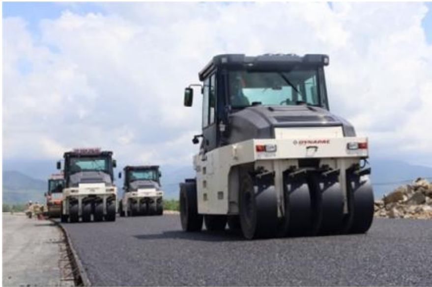
Hệ thống lu lèn nền đường hiện đại giúp giảm nhân công, đẩy nhanh tiến độ dự án
