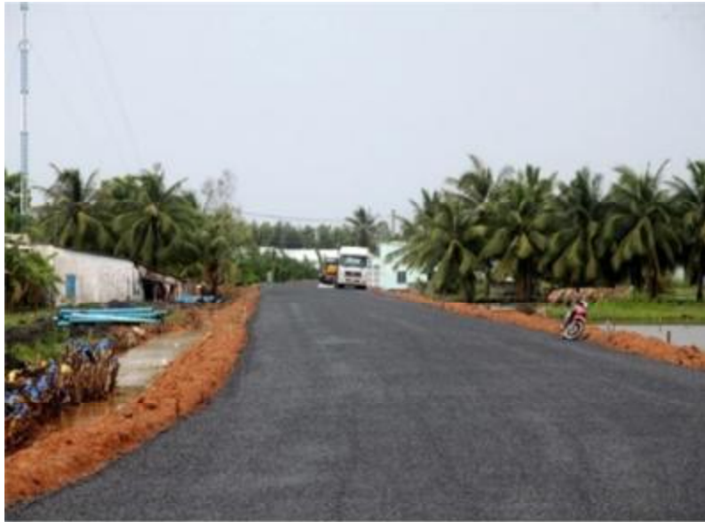
Tuyến đường thuộc Dự án cao tốc Hậu Giang - Cà Mau tại Km79+820 thuộc địa bàn xã Vĩnh Lộc (huyện Hồng Dân) được thí điểm dùng cát biển đắp nền
