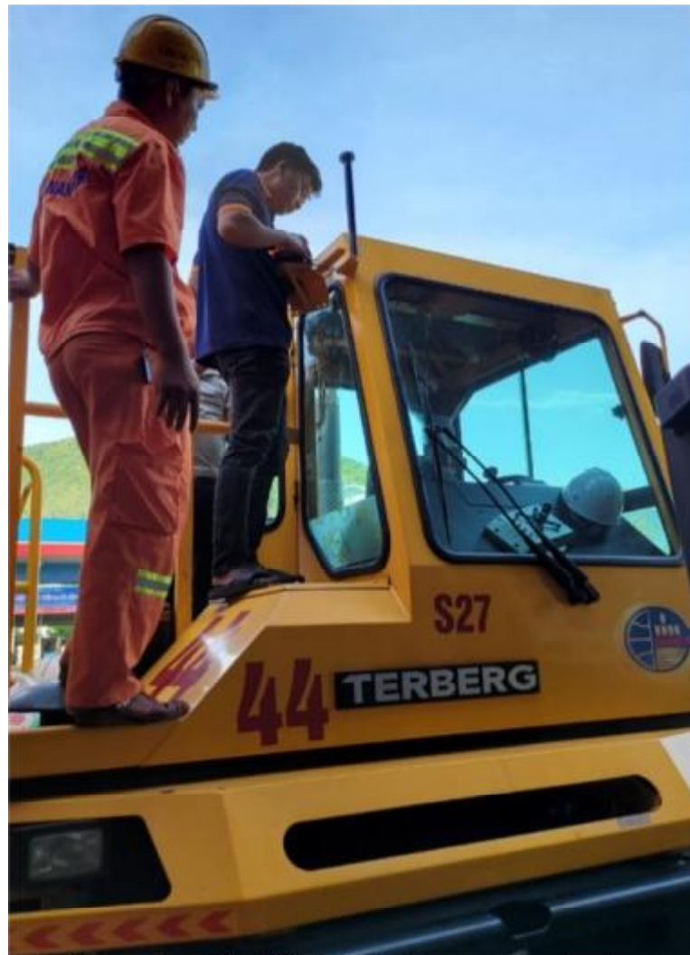
Lắp ráp thiết bị tại xe container
