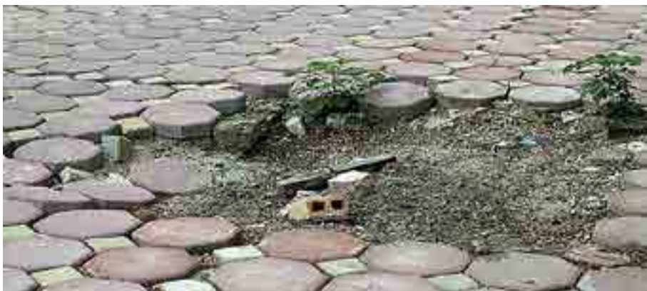
Hình 5. Tại Thái Hà, vỉa hè ở đây được lát gạch hình lục giác, một trong số những loại bền và tốt nhất hiện nay nhưng cũng không „trụ“ nổi sự tác động của con người và môi trường
