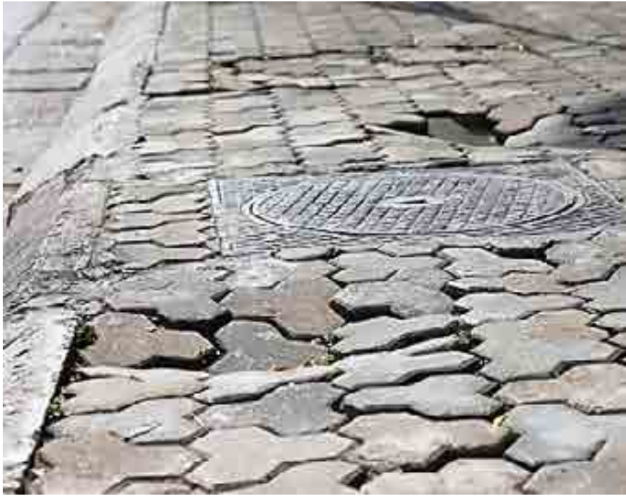
Hình 6. Phố Chùa Bộc cũng lâm vào tình trạng tương tự, vỉa hè được lát gạch terrazzo
