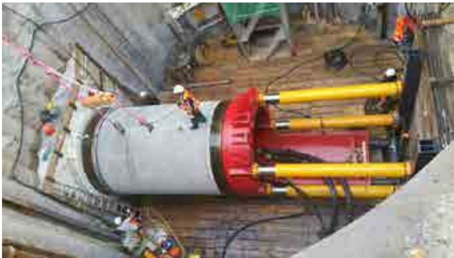
Hình 1.2. Má y khoan kich Pipe Jacking
